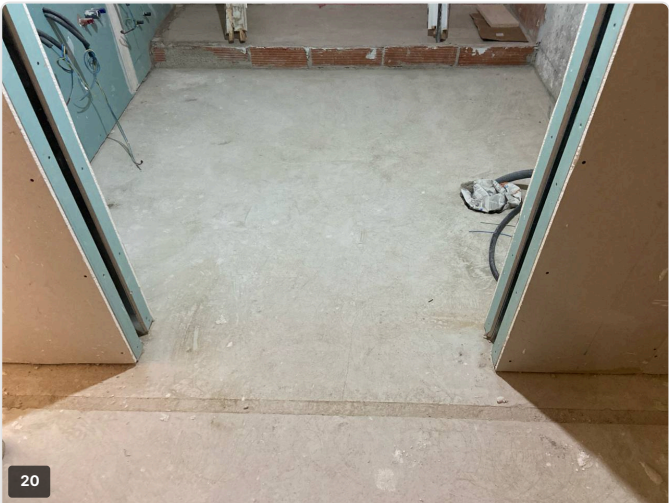
Pavimentos — solera y paso de acceso en vestidor-baño suite
