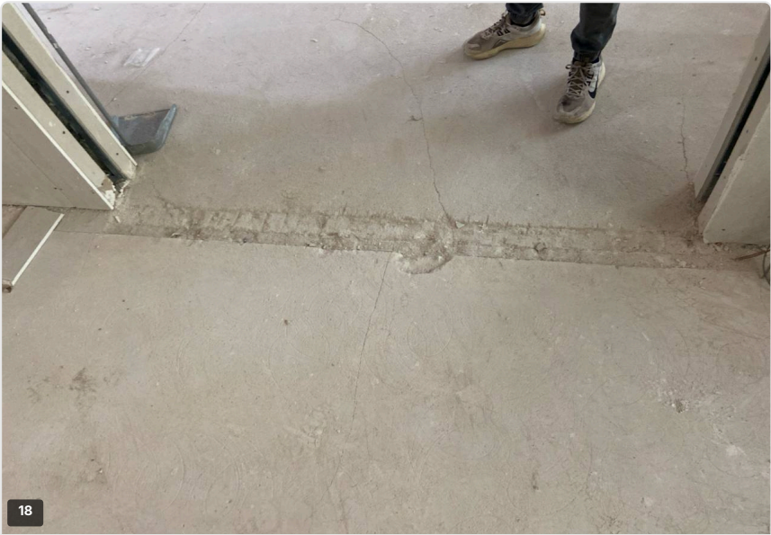
Pavimentos — junta de solera en distribuidor
