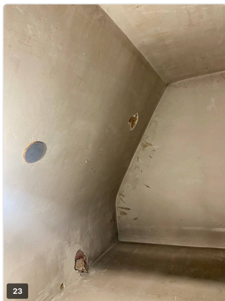
23 Baño 1 — trasdosado curvo y huecos de instalaciones
