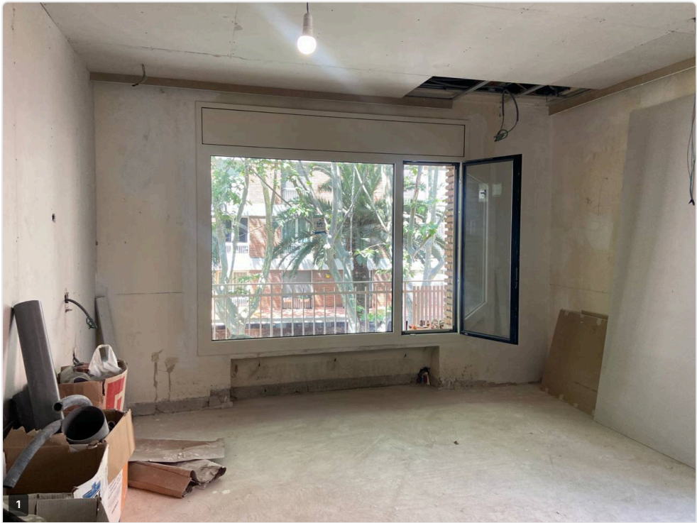
Ventanas — hojas corredera y abatible en colocación
