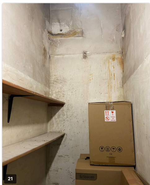
21 Trastero — baldas provisionales y paramentos interiores
