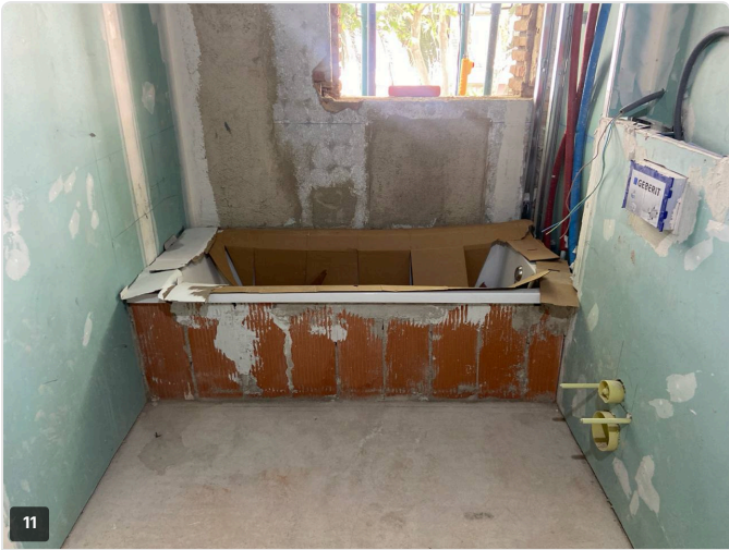
Baño 1 — bañera colocada y trasdosados pendientes
